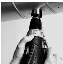
3. Öffnung in Kanal bohren; Lochgröße: **36 mm** Ø
